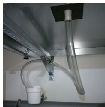
Napojení odvodu kondenzátu
