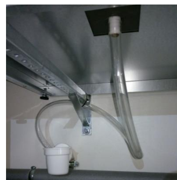
Napojení odvodu kondenzátu
