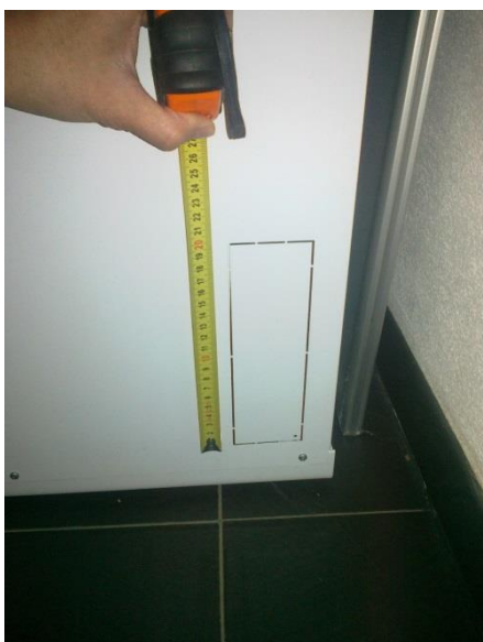
Boční perforovaný prostup (60x200 mm) má odstup hrany prostupu a zadní hrany jednotky 25 mm. Stejně prostupy jsou v levé i pravé boční straně.
