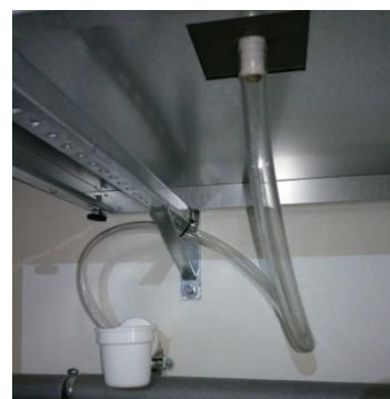
Napojení odvodu kondenzátu
