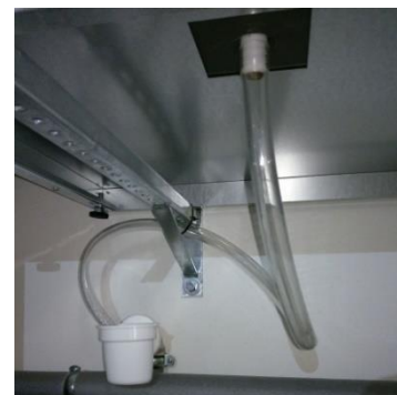
Napojení odvodu kondenzátu
